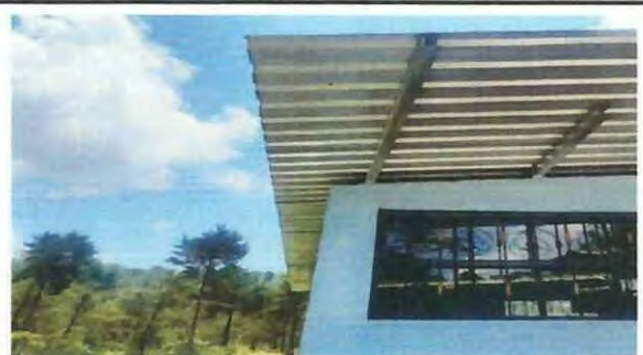
Foto 16: Colocación de canal de metal más pescantes
