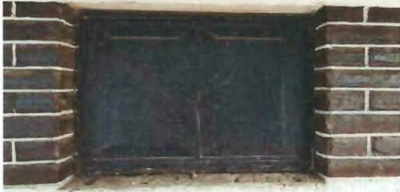
Foto 13: Fabricación y colocación de ventana y balcón de la cocina.
