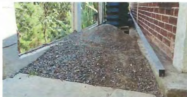
Foto 10: Colocación de losa de concreto pasillo exterior trasero de la cocina
