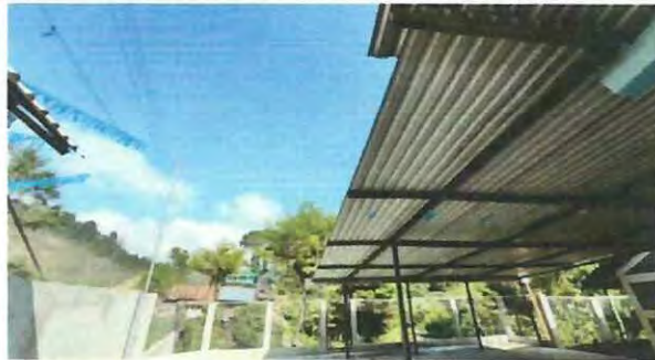
Foto 2: Mejoramiento de estructuras metálicas y colocación de techado de patio
