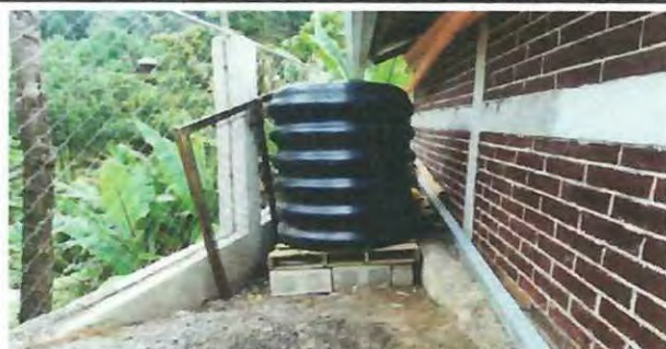
Foto 11: Sustitución de depósito de agua Tíaco de 1100 litros por uno de 2,500 litros más base
