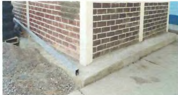
Foto 8: Mejoramiento de banquetas
