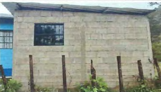
Foto 17: Repello de pared lado trasero del aula de primero primaria
