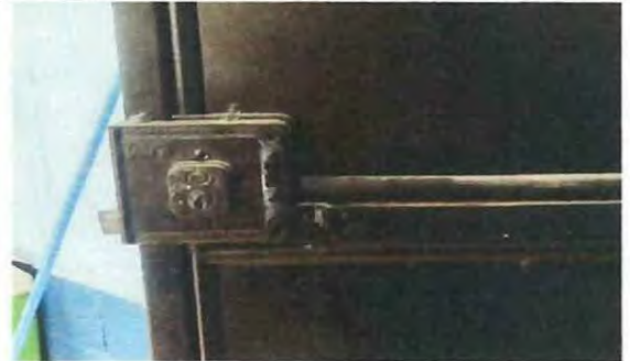
Foto 14: Sustitución de Chapa de la puerta del aula de sexto primaria
