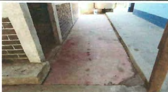
Foto 4: Sustitución de piso liso por piso cerámico en el pasillo exterior frontal de la cocina
