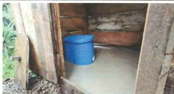
Foto 20: Sustitución de Sanitario de Plastico por Sanitario Lavable primaria
