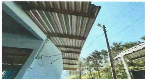
Foto 1: Mejoramiento de estructuras metálicas y colocación de techado de patio
