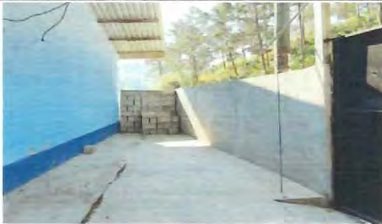
Foto 19: Seguimiento de cernido de paredes, más block.
