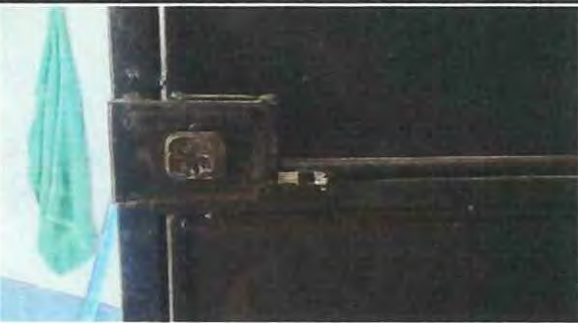
Foto 15: Sustitución de Chapa de la puerta del aula de preprimaria
