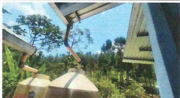
Foto 3: Ampliación de techado lado frontal del aula de primero
